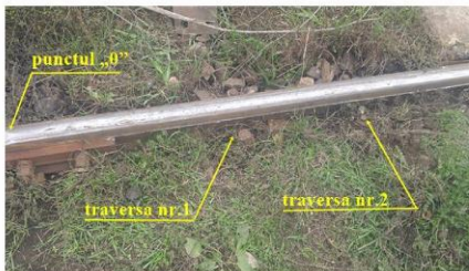
Fig.7-starea tehnică a traverselor nr.1 și nr.2
