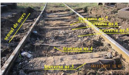
Fig.8-starea tehnică a traverselor aflate în cuprinsul trecerii la nivel
