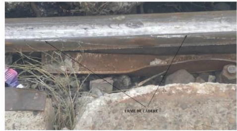
Fig.5-urme de cădere între firele căii în cuprinsul trecerii la nivel
